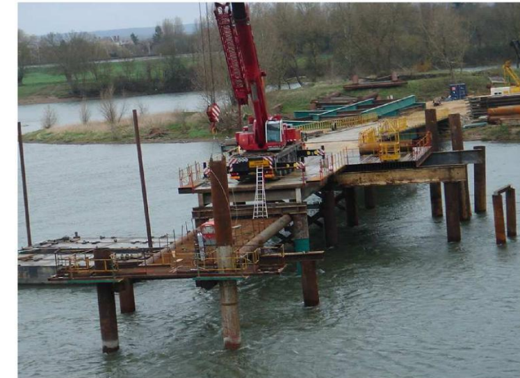
Exemple de construction d'estacade (source : leductp.com )
