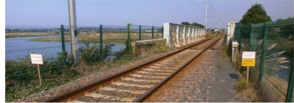
Signalétique du franchissement dangereux et même « interdit » du tablier. Source : SCE et SNCF
