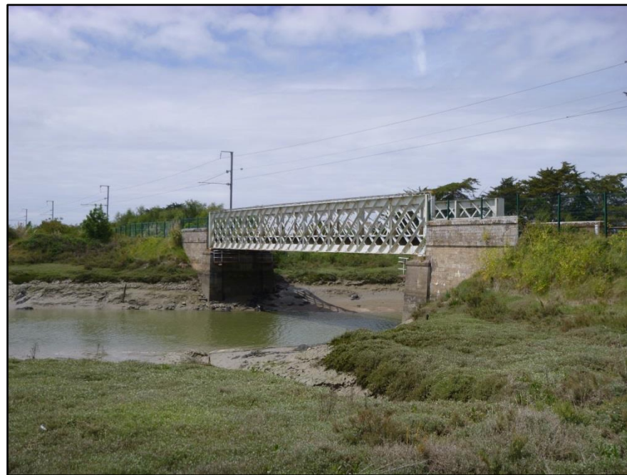
Figure 1 : Vue de l'ouvrage actuel côté Sud
