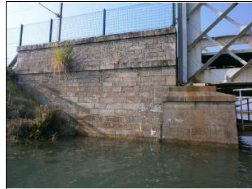
Figure 3 : Vue du chemisage en béton réalisé en 1964/1965
